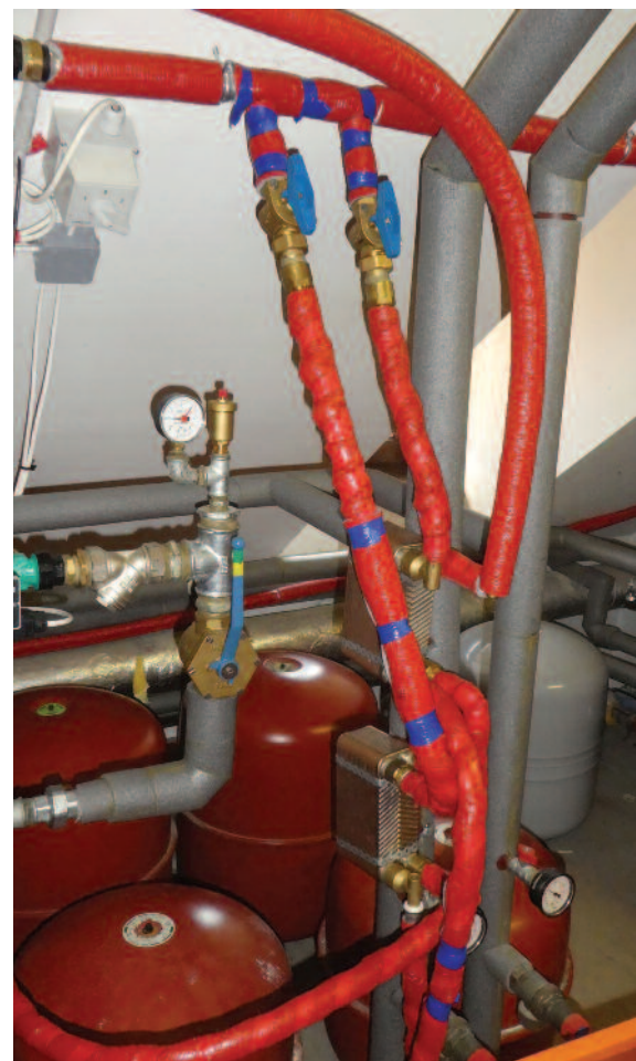
1. kép – Hőközpont terv nélküli szerelése
