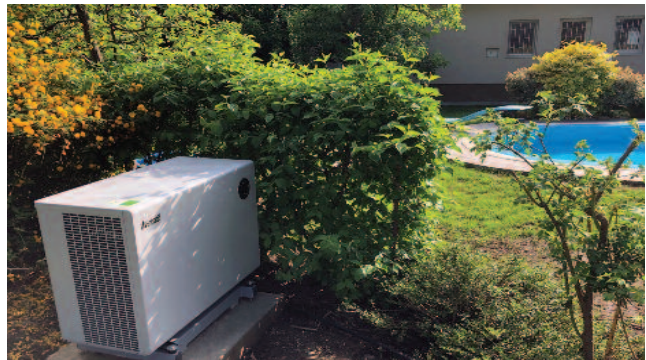
7. ábra – Medence mellé telepített hőszivattyú, diszkréten megbújva a növényzet mögött
