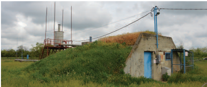
2. kép – Távlati kép a gáztalanítóról és az I. jelű szivattyúházzal
