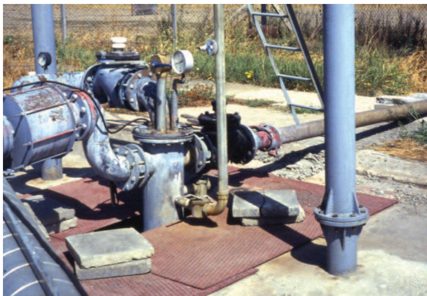
1. kép – A K-38-as termálkút kútfeje
