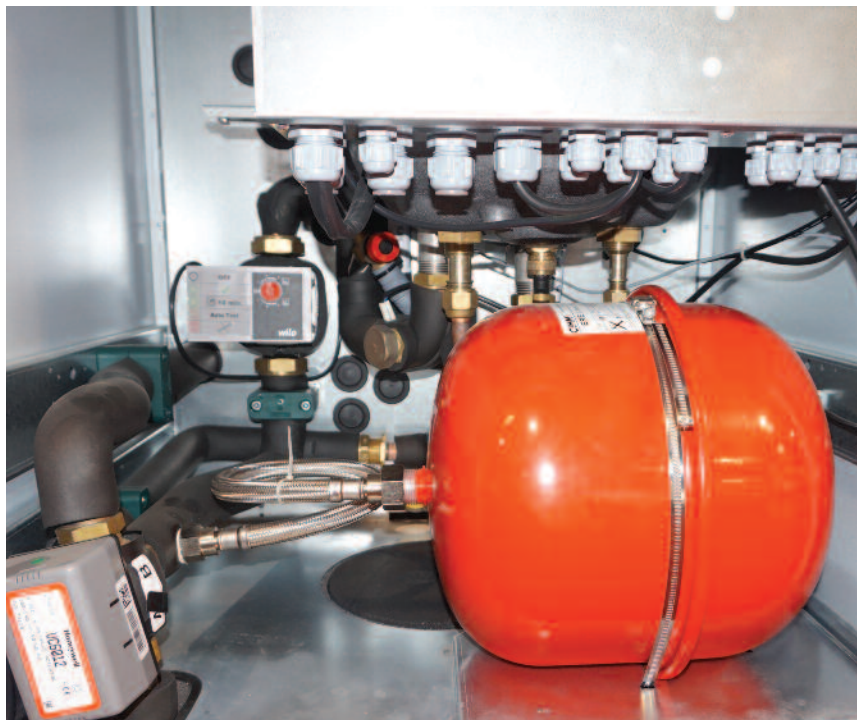
A gyári táglási tartály nem mindig elegendő az adott rendszerhez
