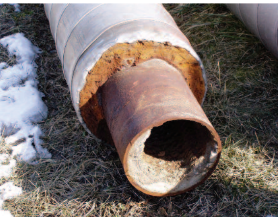
Az elkövesedett szállítóvezeték
