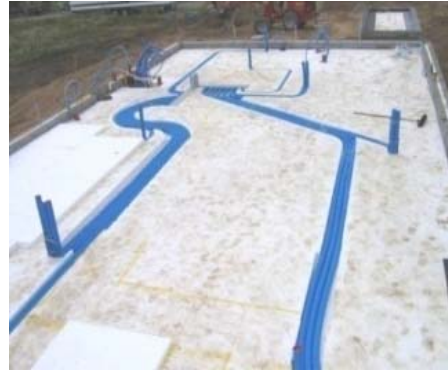
Dániai építkezés - Lindab InDomo rendszer hőszigetelő rétegben
