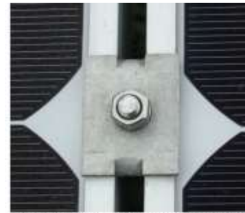
1. számú kép: rozsdamentes acélból készült anyacsavar.
