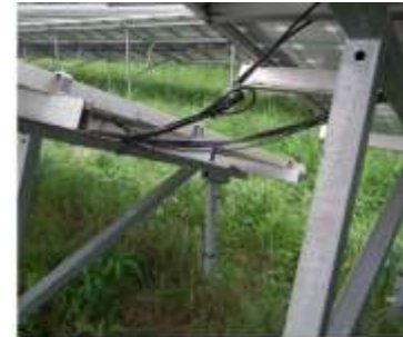
3. számú kép: az összekötő vezetékek feszültségből adódó terhelése.
