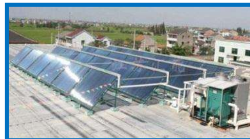
Solar Cooling Napkollektoros hűtés
