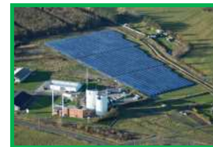
Solar District Heating Napkollektoros távfűtés
