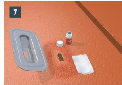
7 A felcsiszolt lemezek tisztítása tisztítófolyadékkal
