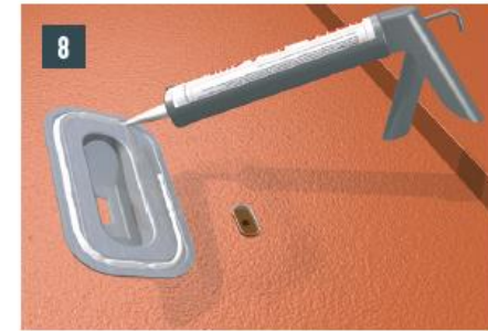
8 10mm Ø ragasztócsík felhordá-sa a tiszta Sunny elemre
