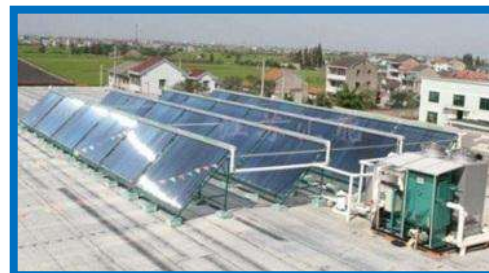
Solar Cooling Napkollektoros hűtés
