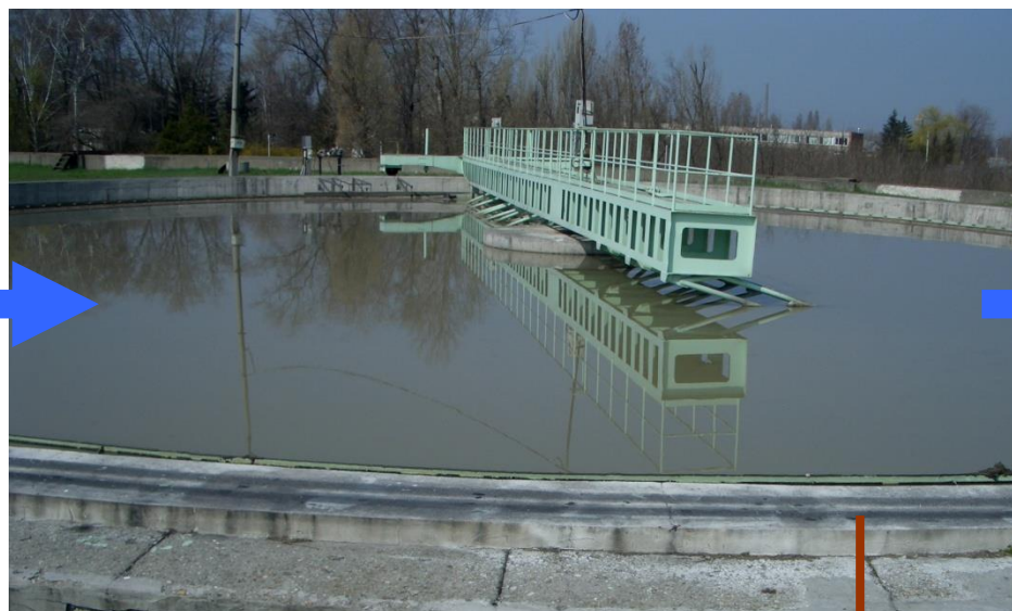
előülepítő medence a nyersiszap eltávolítására
