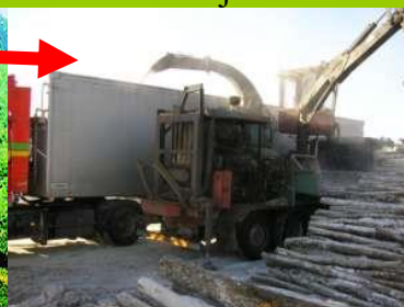
Közvetlen ráfűjés a kamionra
